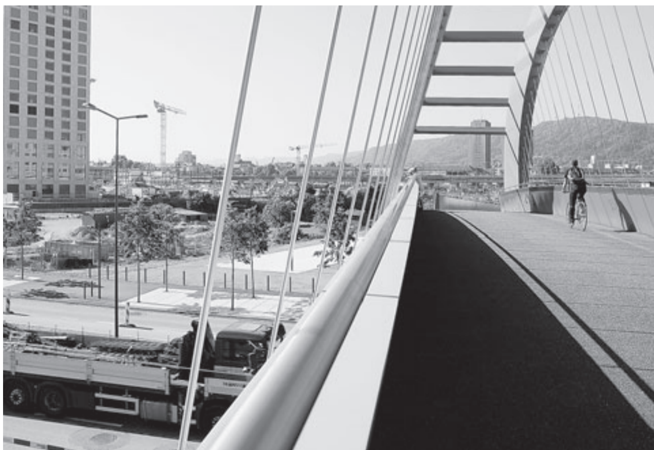
Die Infrastruktur für Fuss- und Veloverkehr geniesst in Neubaugebieten von Anfang an einen hohen Stellenwert. Hier die Passerelle über die Pfingstweidstrasse im Entwicklungsgebiet Zürich-West im Mai 2011.
